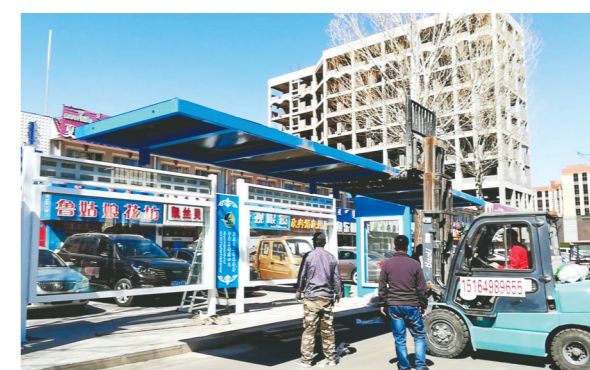
施工工人正在安装全新候车亭
